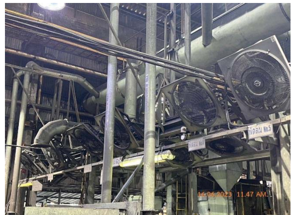
ภาพที่ 48 พัฒนาระบายอากาศช่วยลดความร้อน
