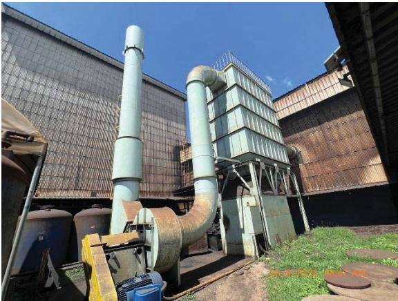
ภาพที่ 3 ปล่องระบบดักฝุ่นจาก Finishing & Grinding (Line ACE)
