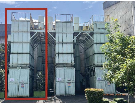
ภาพที่ 7 ปล่องระบบดักฝุ่นจาก Finishing & Grinding No. 2 (Line AMF)
