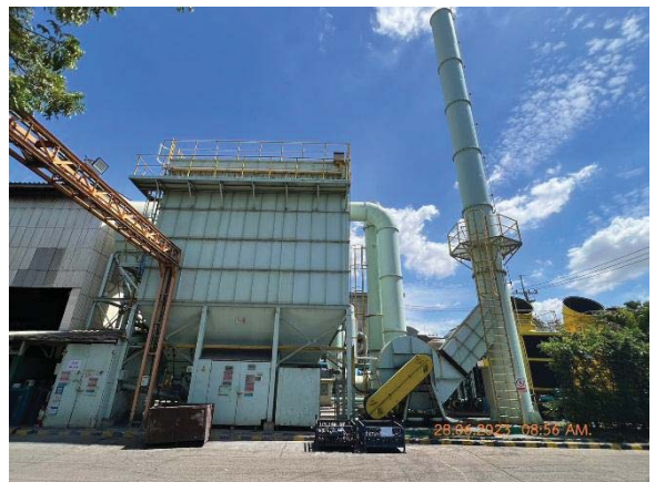
ภาพที่ 6 ปล่องระบบดักฝุ่นจาก Melting furnace No.1&2 (Line ACE)
